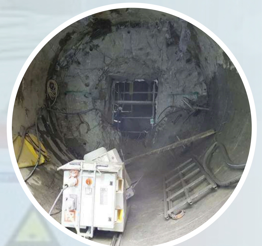
Corte de Boca Túnel en Concreto
