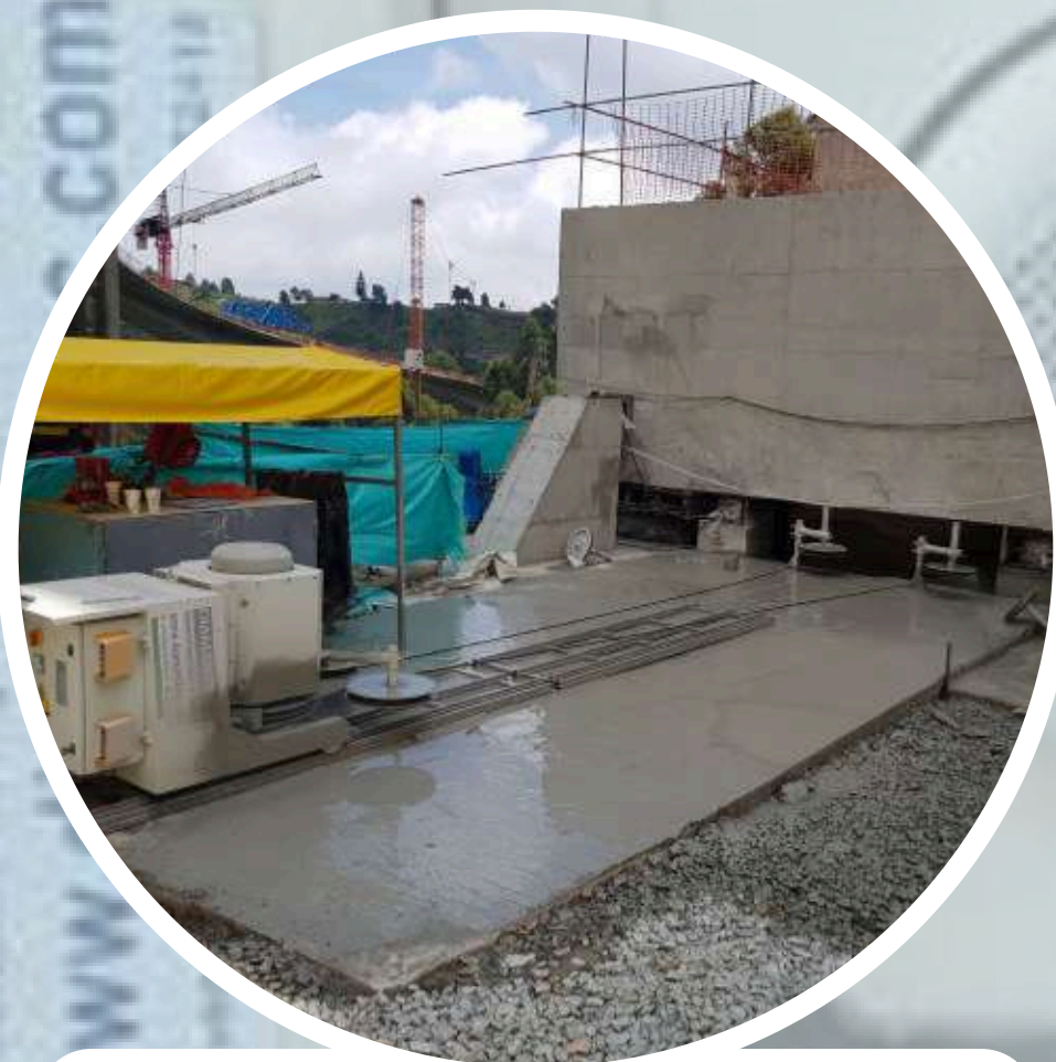
Corte de Pilas en Concreto
